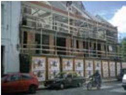
Se deben colocar barandas estables y resistentes a 1 m, 0,50 m y zócalo de 0,15 m con travesaños intermedios en todos los lados expuestos.
