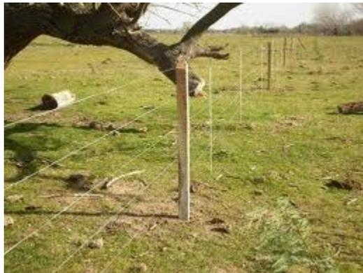
**ALAMBRADOS.** — La subdivisión se efectúa mediante alambrados, en cuya construcción intervienen los siguientes elementos: postes, medios postes, varillas, alambres y torniquetes.
