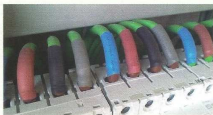
Figura 2.13. Marcado manual del cableado en base al código de colores.
