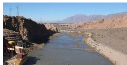
Vista de la represa Quebrada de Ullum.
