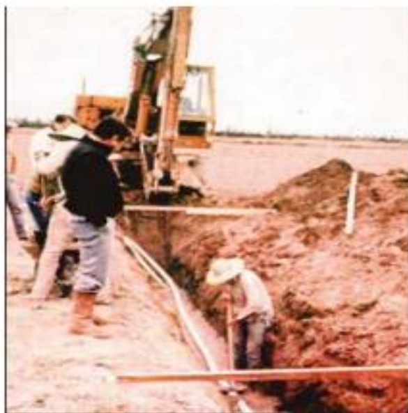
Foto11 Construcción de un dren entubado.
