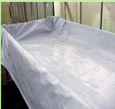
Estructura de madera cubierta con polietileno.
