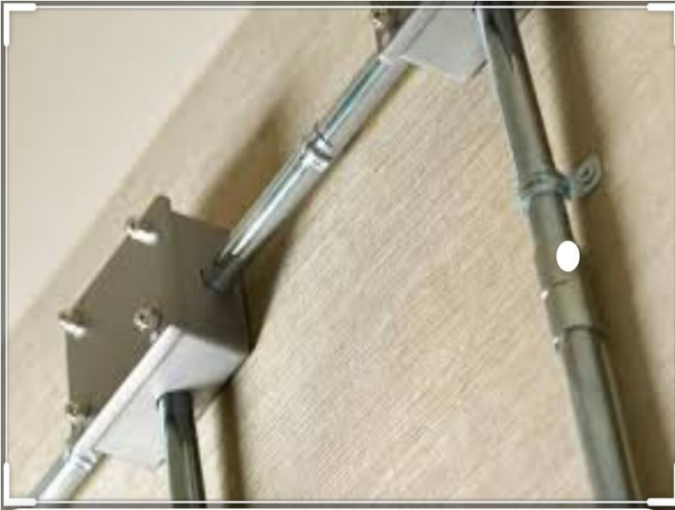
SISTEMA INSTALACIÓN CON CAÑO ALUMINIO TIPO DAISA
